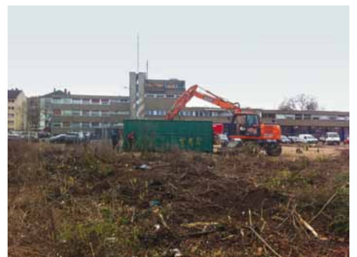
Nach der Fällung von Bäumen und Sträuchern hat man vom Bahnhof aus nun freie Sicht auf die Feuerwache – allerdings nicht mehr lange, diese wird auch bald abgerissen. Bild: Syri
